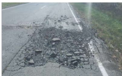
Участок до строительства
